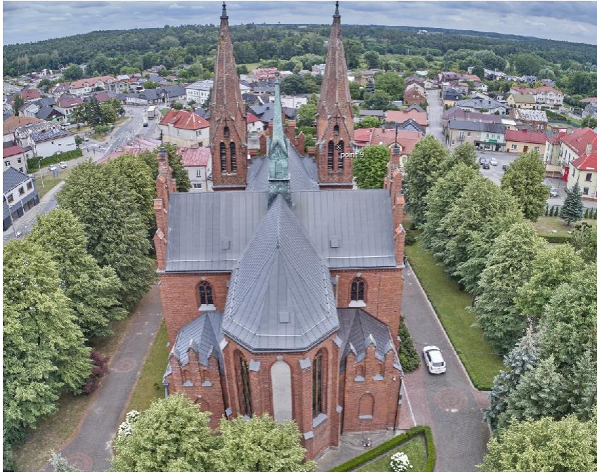
zdj. 5 Elewacja zachodnia
