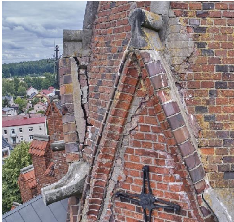
zdj. 35 Spękania wimpergów
