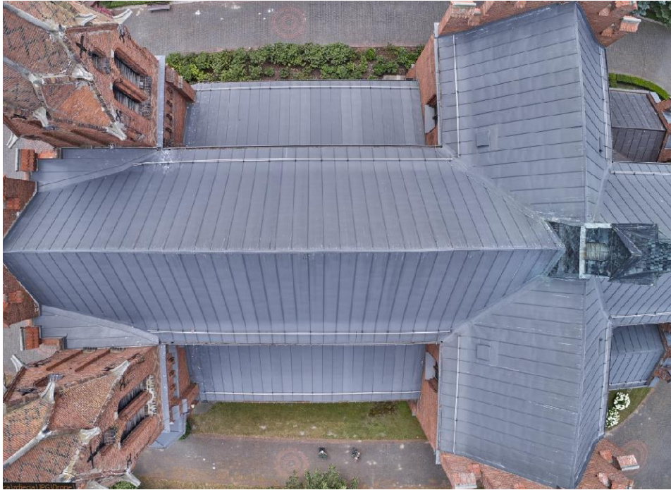
zdj. 7 Układ płotków przeciwniegowych na dachu
