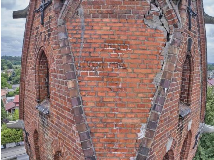
zdj. 25 Wtórne przemurowania wimpergów
