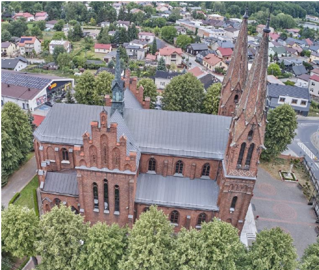
zdj. 4 Elewacja południowa
