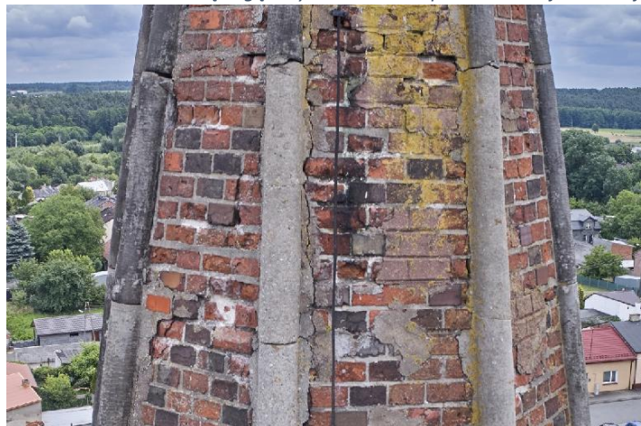
zdj. 24 Betonowe kopie gąsiorów
