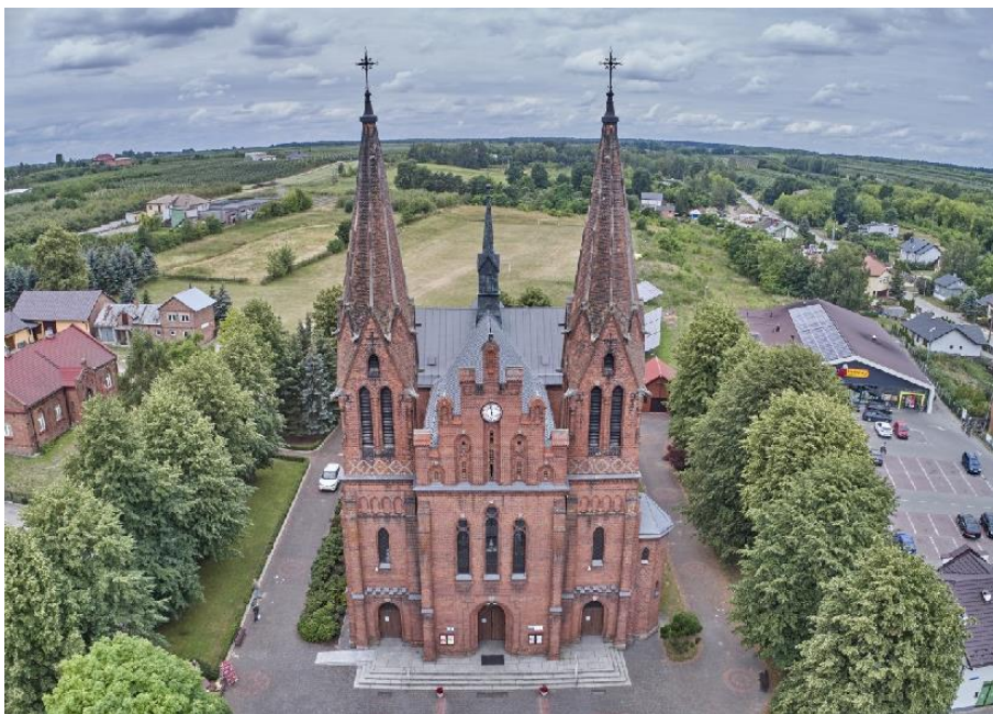
zdj. 2 Elewacja wschodnia- frontowa
