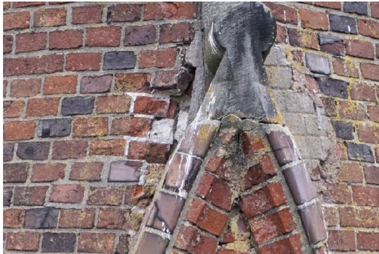
zdj. 36 Spękania na szczycie wimpergi
