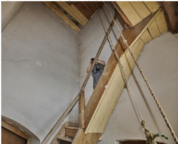
zdj. 17 Schody drewniane na z drugiej kondygnacji wieży północnej prowadzące na poddasze
