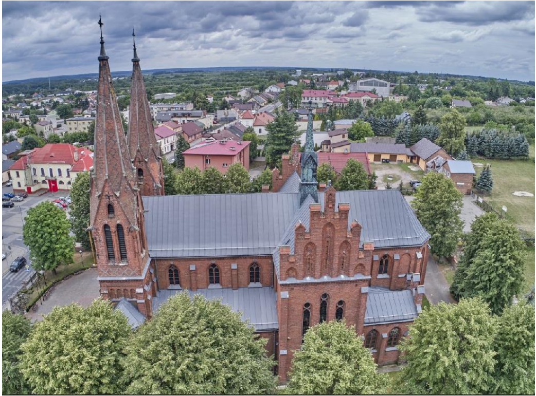
zdj. 3 Elewacja północna
