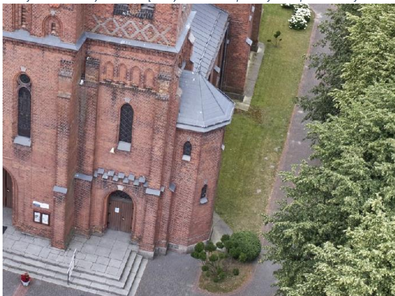
zdj. 19 Klatka schodowa ze schodami kręconymi znajdująca się w przybudówce do wieży północnej
