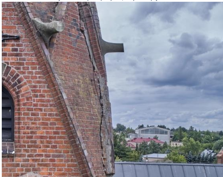
zdj. 42 Spękania wimpergów
