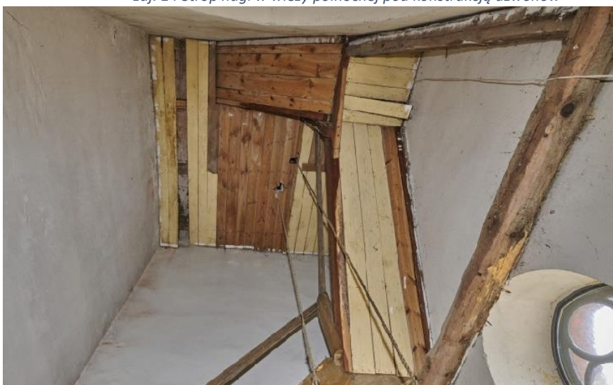
zdj. 15 Sufit stropu w wieży północnej nad II kondygnacją
