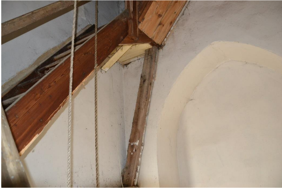
zdj. 10 Ściany w wieży północnej na poziomie drógiej klatki schodowej
