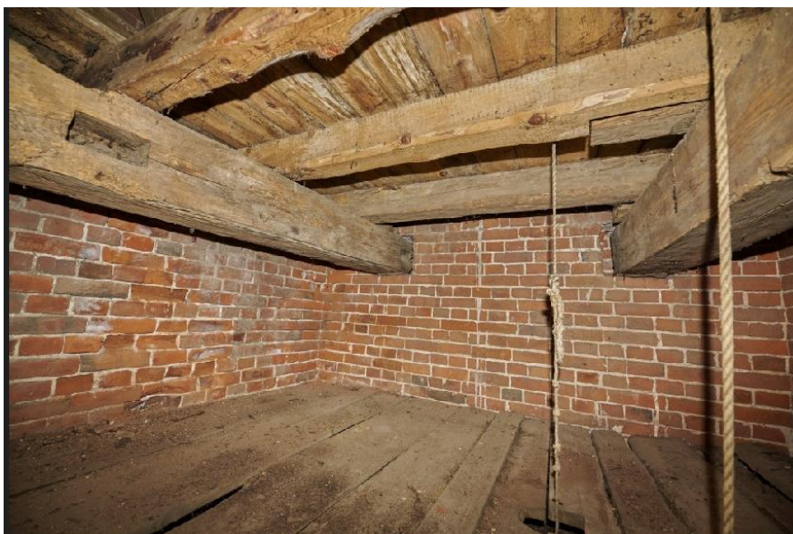
zdj. 14 Strop nagi w wieży północnej pod konstrukcją dzwonów
