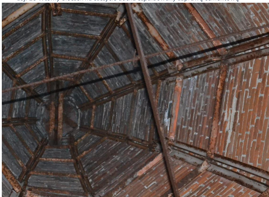
zdj. 21 Wtórne wewnętrzne wzmocnienia wieży kątowników spawanych
