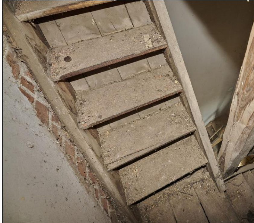
zdj. 22 Odcięcie tynku po lewej stronie na ostatnim biegi schodów w wieży północnej - prawdopodobnie w tym miejscu pierwotnie znajdował się inny bieg schodów
